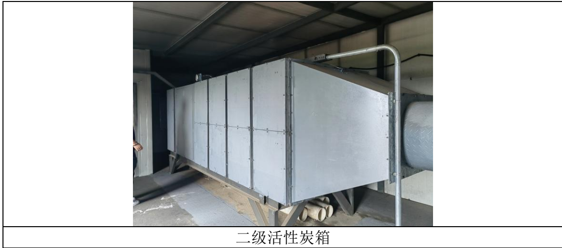
图 2-7 现有废气治理设施照片
