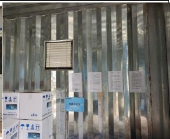
危废暂存间内部
