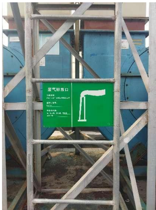
排气筒 DA001 标识牌
