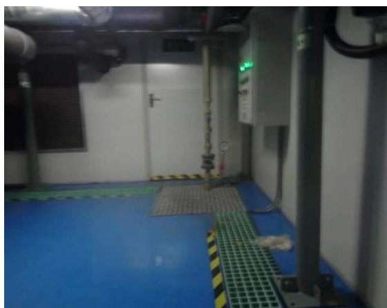
生产车间边沟及基坑
