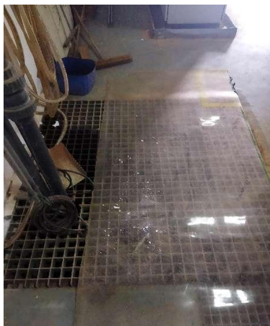
污水处理站基坑
