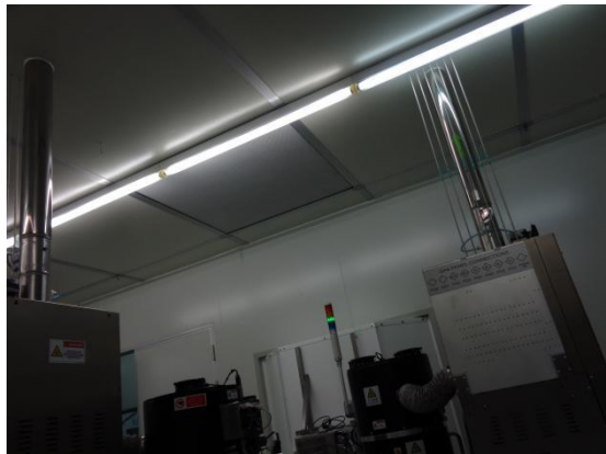
干法刻蚀集气管道
