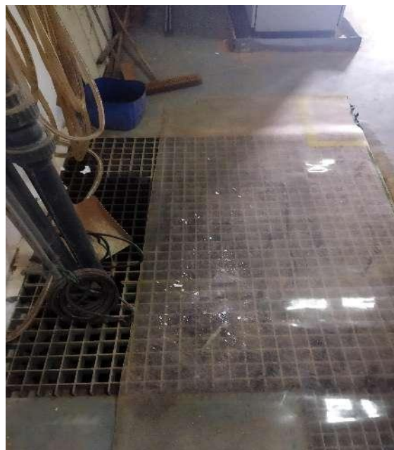
污水处理站基坑
