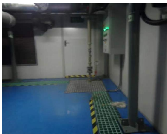
生产车间边沟及基坑
