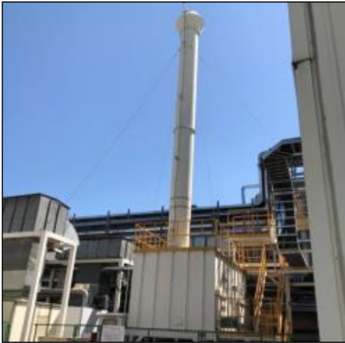
2#真空电解液注入和打码废气排气筒 DA011 及规范化
