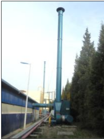
废电池放电间废气排气筒 DA002 及规范化
