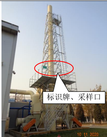
污水站废气排气筒 DA013 及规范化
