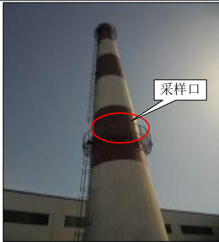
锅炉燃气废气排气筒 DA012 及规范化
