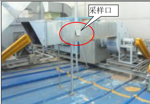
A#阳极极板投料废气排放口 DA004 及规范化
