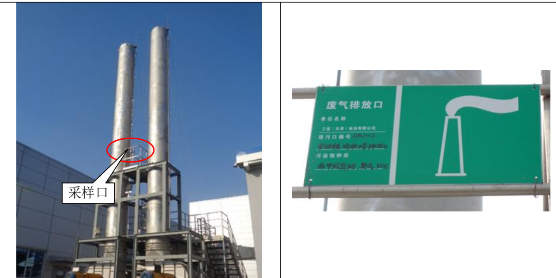
三星电池安评栋排气筒 P2-17 (DA016) 排污口规范化
