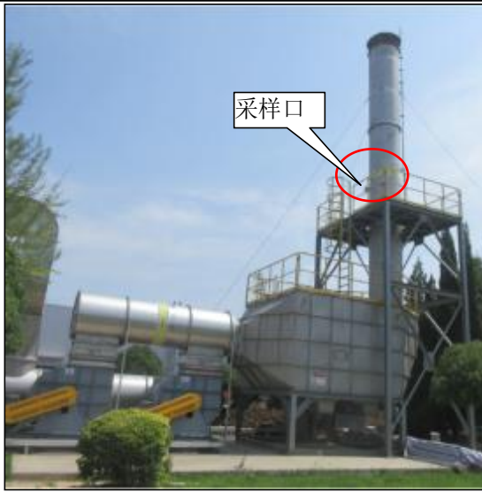
1#真空电解液注入和打码废气排气筒 DA008 及规范化
