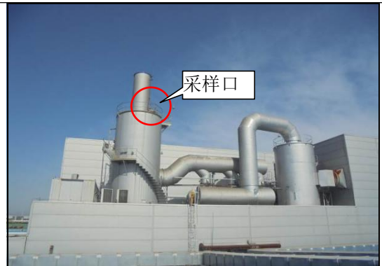
A#极板干燥废气排放口 DA010 及规范化
