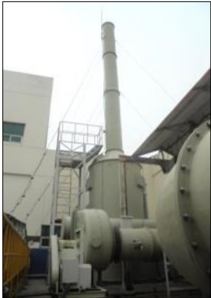
污水站洗涤塔排气筒 DA003 及规范化
