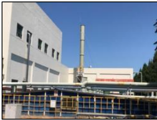
废水污水处理站
