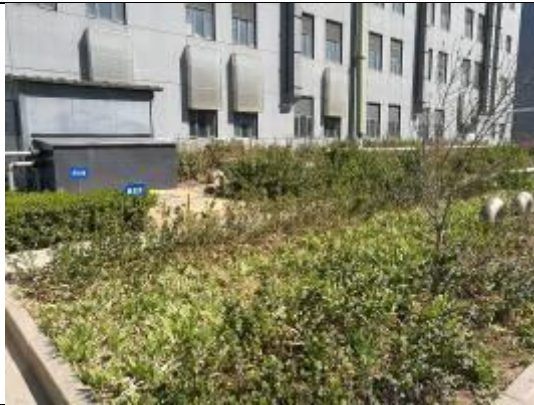
南海路厂区地埋式污水处理站
