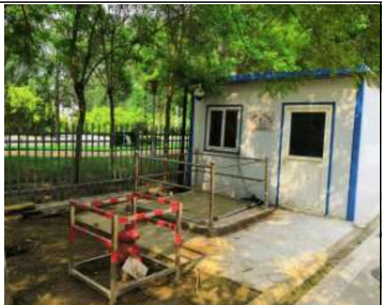
废水总排口（屋内为在线设备）
