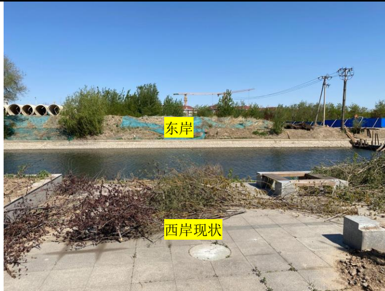
图 1-5 桥台搭设临时占地
