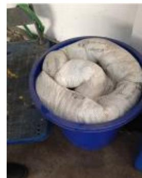
危废库房内的防撒漏危废储存托盘及处置危废洒漏用的吸附材料
